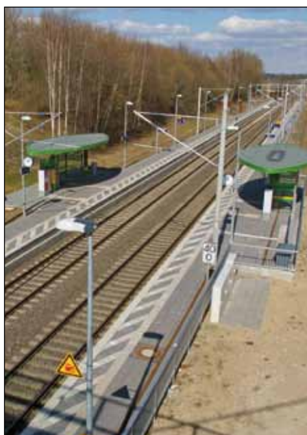
Haltepunkt Strecke Lübeck - Hamburg, Blick auf die Gesamtanlage (Foto: Schröder / ISB)
