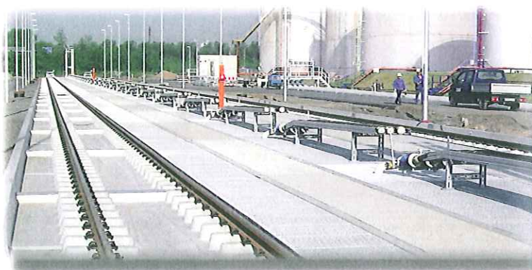
Kesselwagen-Entladestation
