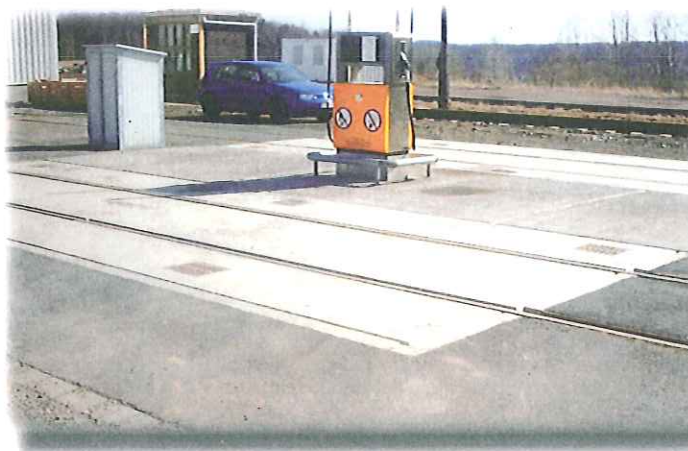
Gleiswanne mit befahrbarer Betonabdeckung
