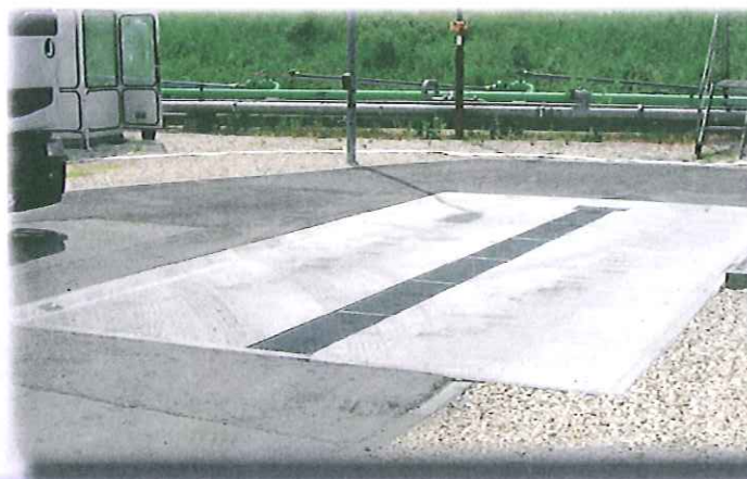
LKW-Entladestation für Bio-Ethanol
