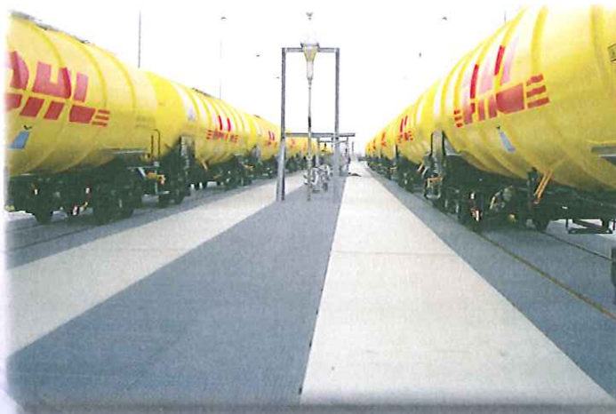
Ableitflächen für Kerosinentladung (DHL Luftfrachtdrehkreuz am Flughafen Leipzig/Halle)
