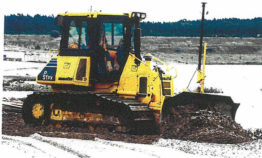
Planieren mit GPS: Der Baumaschinenführer hat es heute auch mit modernster Technik zu tun. (Foto: SGL)
