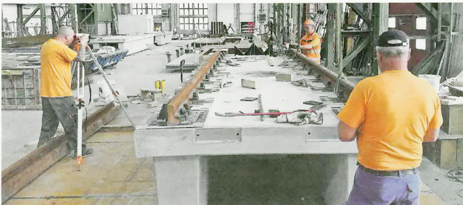
Präzision ist bei der Fertigung der tonnenschweren Betonteile in den Produktionshallen der B+F Lauchhammer gefragt. Das Werk stellt unter anderem Gleistragplatten her.
